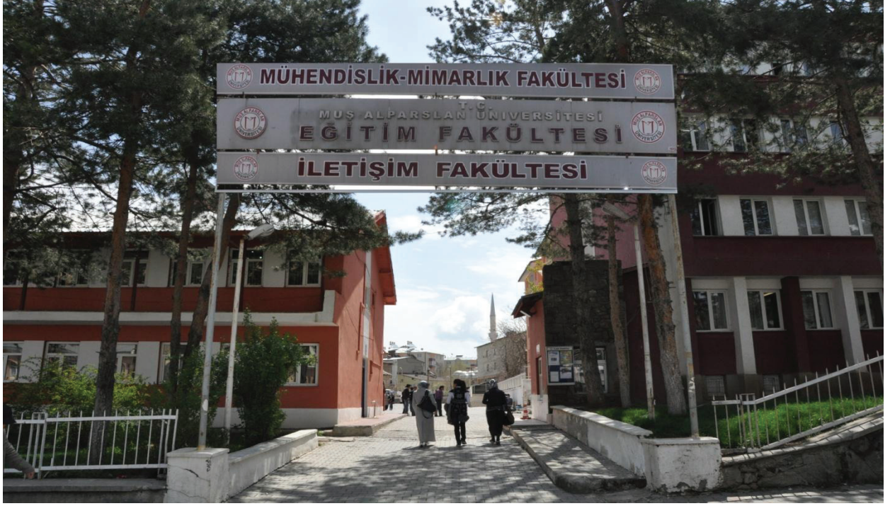
Resim 1. Mühendislik-Mimarlık Fakültesi, Eğitim Fakültesi ile İletişim Fakültesi hizmet binası.
