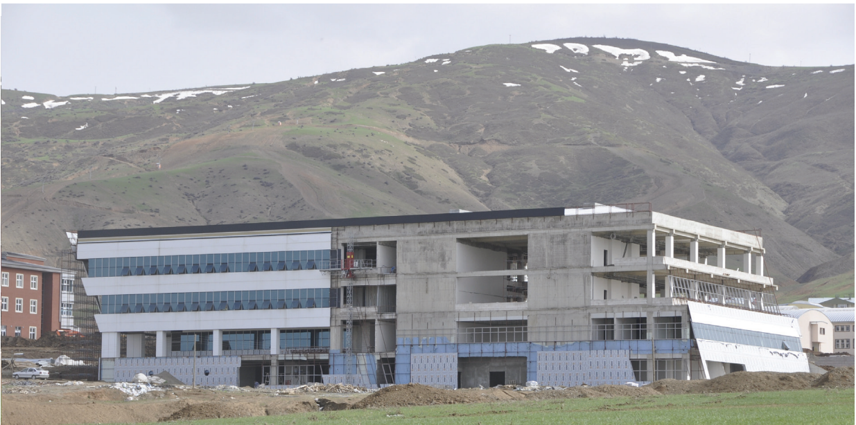
Resim 14. Yapımı Devam Eden Kütüphane ve Bilgi İşlem Merkezi.
